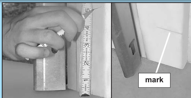
FIG. 4-1 Mark door frame.
