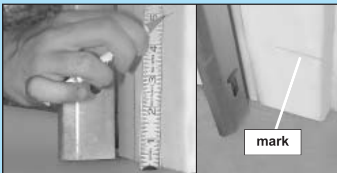
FIG. 3-1 Mark door frame.
