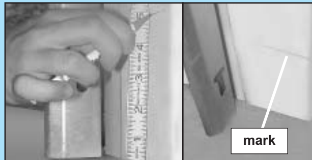
FIG. 3-1 Mark door frame.
