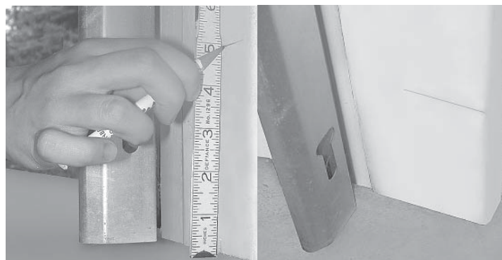
FIG. 4-1 Mark door frame.
